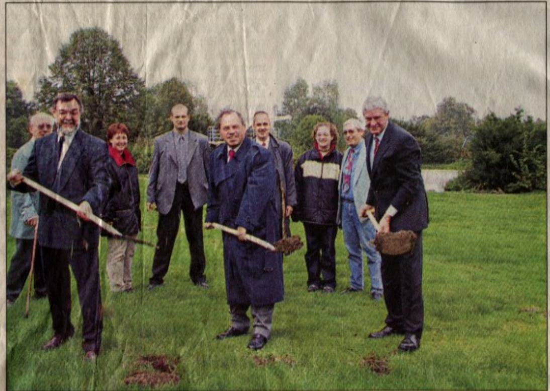
DER OFFIZIELLE STARTSCHUSS für die Sanierung des Freibades fiel gestern mit dem ersten Spatenstich durch Oberbürgermeister Bernd Doll (Mitte), Peter Solberg (links) und Jürgen Fritz. Foto: Josh
